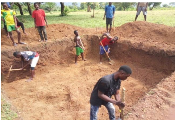
Fouilles pour les latrines à Govié.
